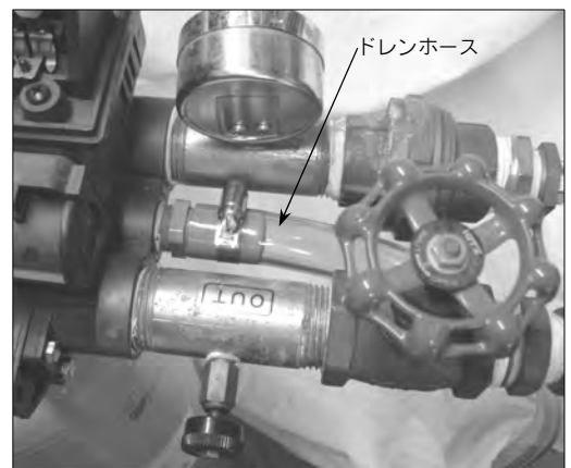
(写真-15)自動弁へのドレンホースの接続
