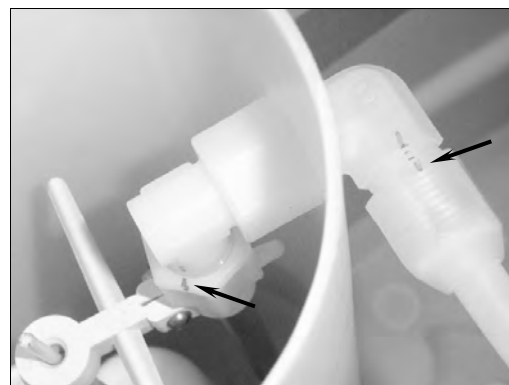
(写真-4) ブラインバルブ周りのナット確認
