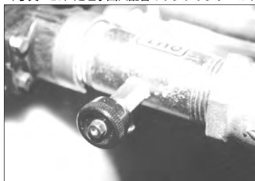
（写真-21）処理水出口配管のサンプリングバルブ
