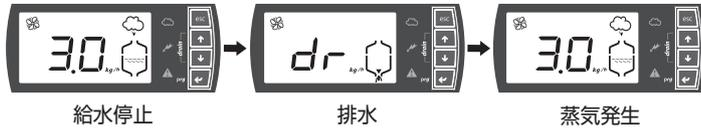
④蒸気シリンダ内の水の濃度を検知しながら、加湿による水位低下と給水を繰り返します。
