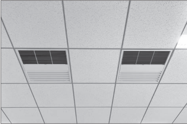
グリッド天井に取り付けられた 滴下浸透気化式 /VCK1500 (てんまい加湿器)
