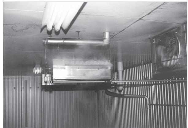
エアハンドリングユニットの横に取り付けられた電熱式 / SJB タイプと軟水器 WSC (旧型式) タイプ
